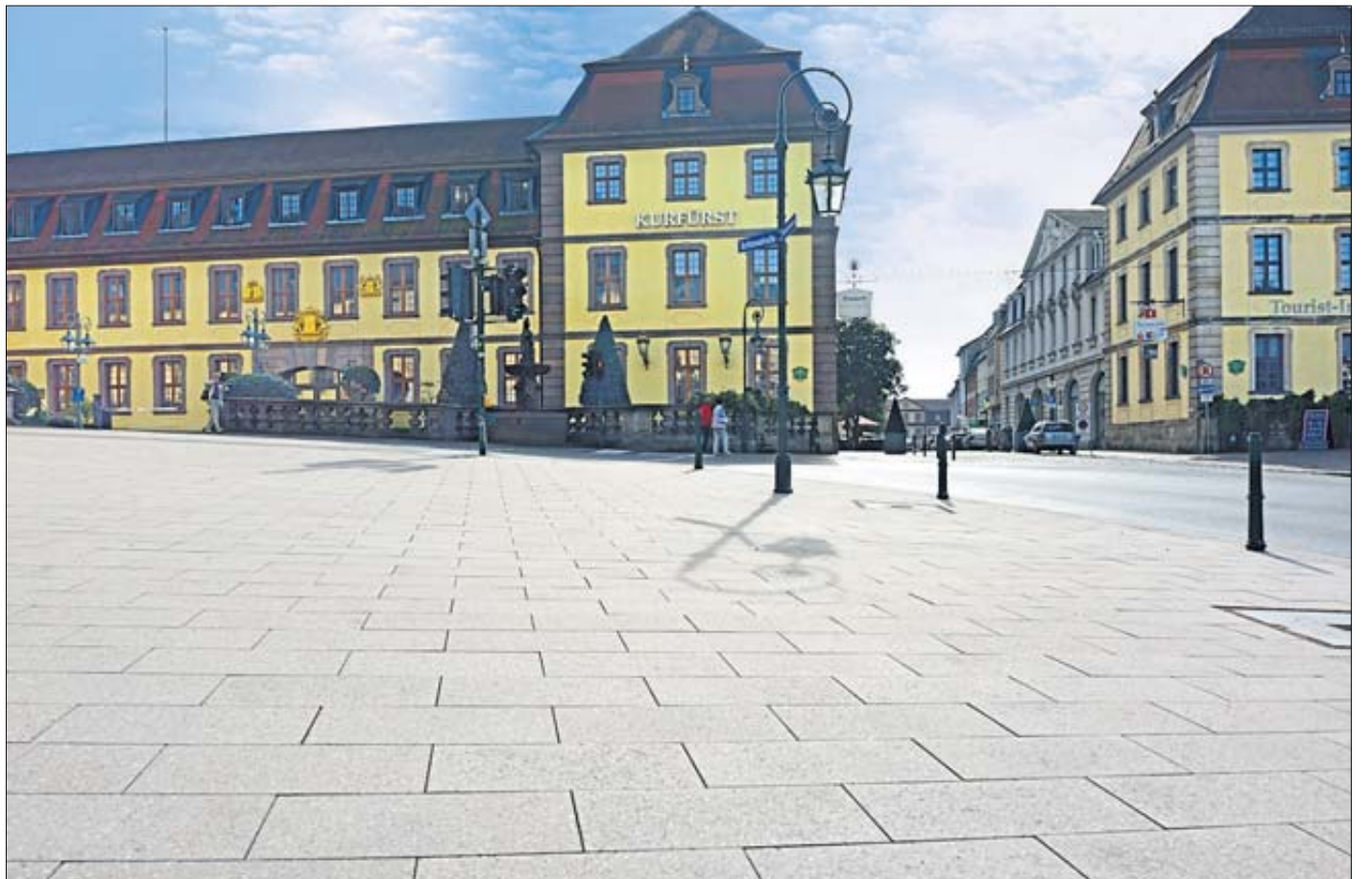
Das Pflaster vor dem Stadtschloss, inmitten von Fulda, wurde von der Firma FC Nüdling hergestellt. Foto: Unternehmen
